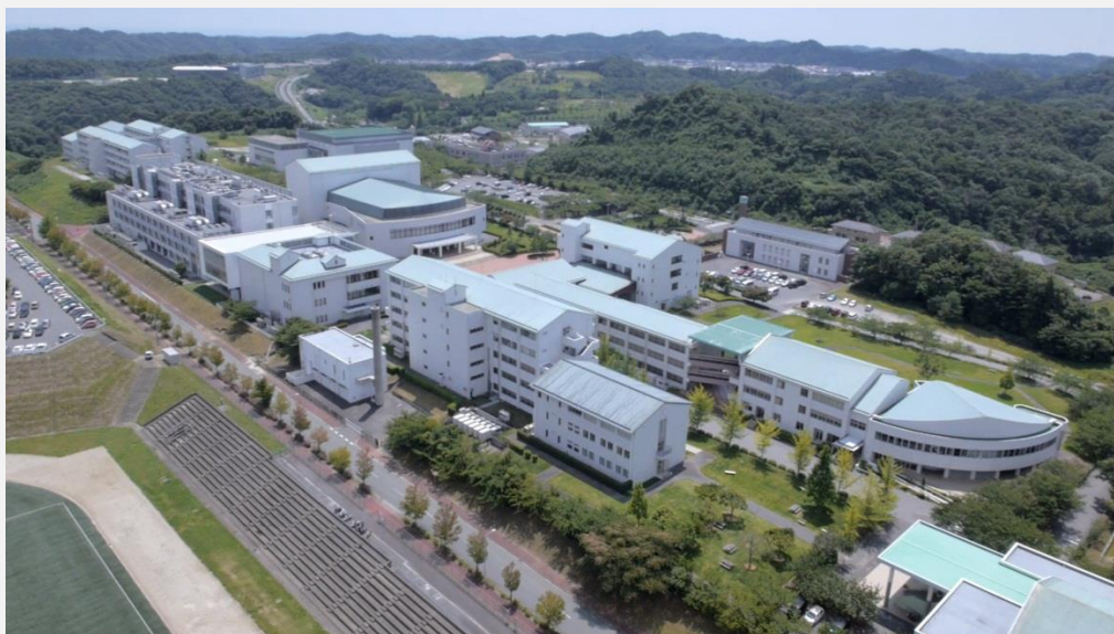
北西方向から見た全景
